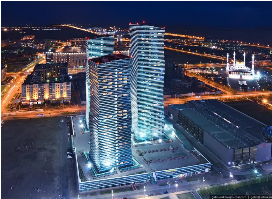
Жилой комплекс «Северное сияние» 155 метров
